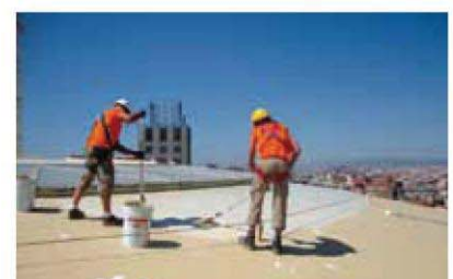
IMPERMAX + верхний слой (Colodur)
