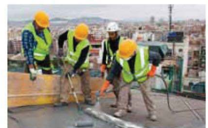
Установка IMPERMAX + Rayston Fiber
