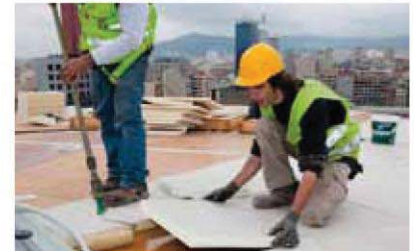
Установка Rayston FOAM (изоляционный слой)
